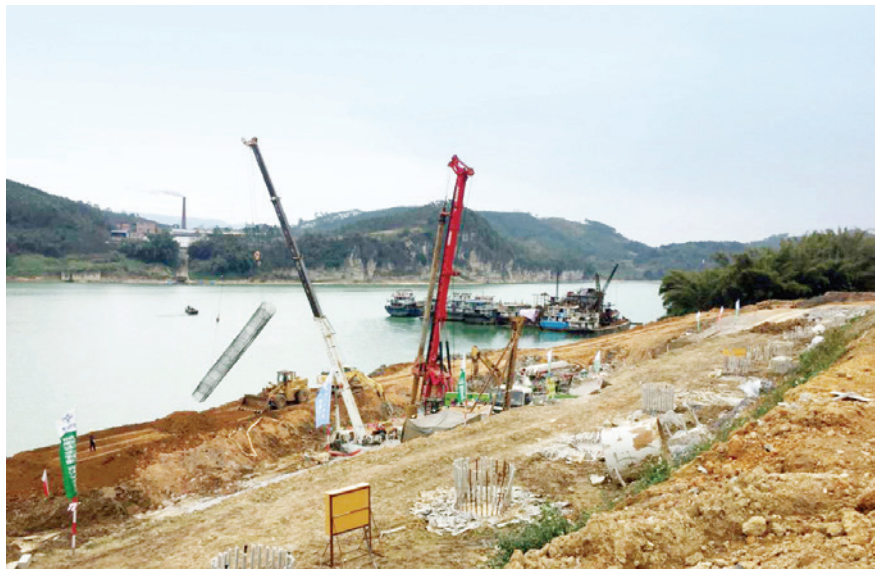
2018年7月,柳州港鹿寨区江口作业区施工现场
