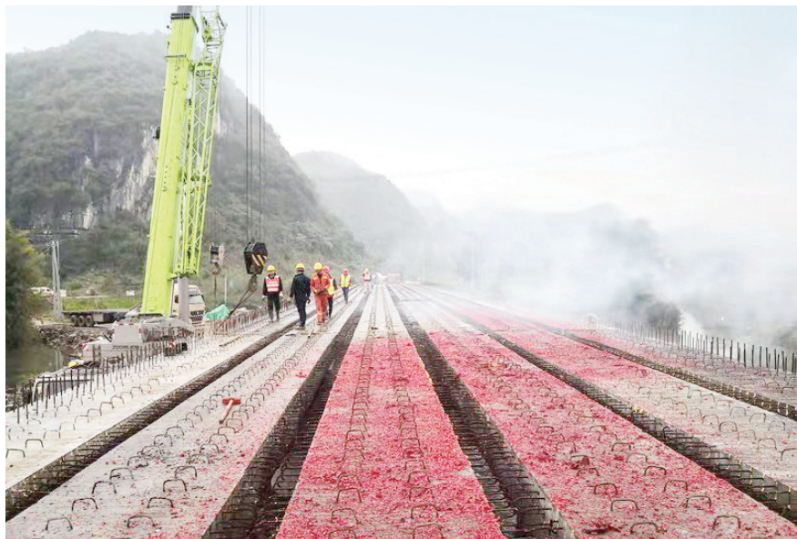
2018年8月,鹿寨经平山至柳城公路施工现场
